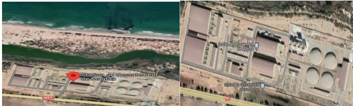
Figure II 3: Photo aérienne de près et de loin de la station de dessalement de Maqtaa.
