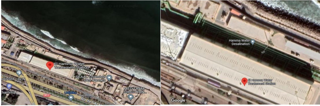
Figure II 2: Photo aérienne de près et de loin de la station de dessalement de Hamma.
