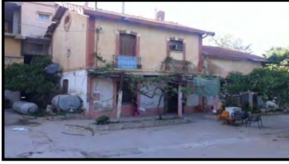
Figure 86 : Photo de la maison. Source : Réalisé par l'auteur.
