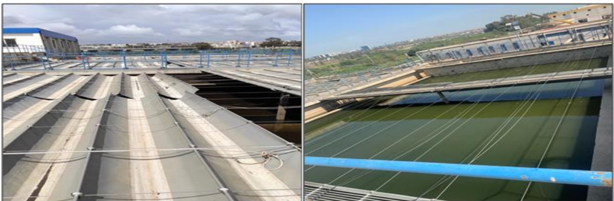
Figure II.19. Lit de sable, filtration par filtres Aquasures (photo prise sur terrain 2023)
