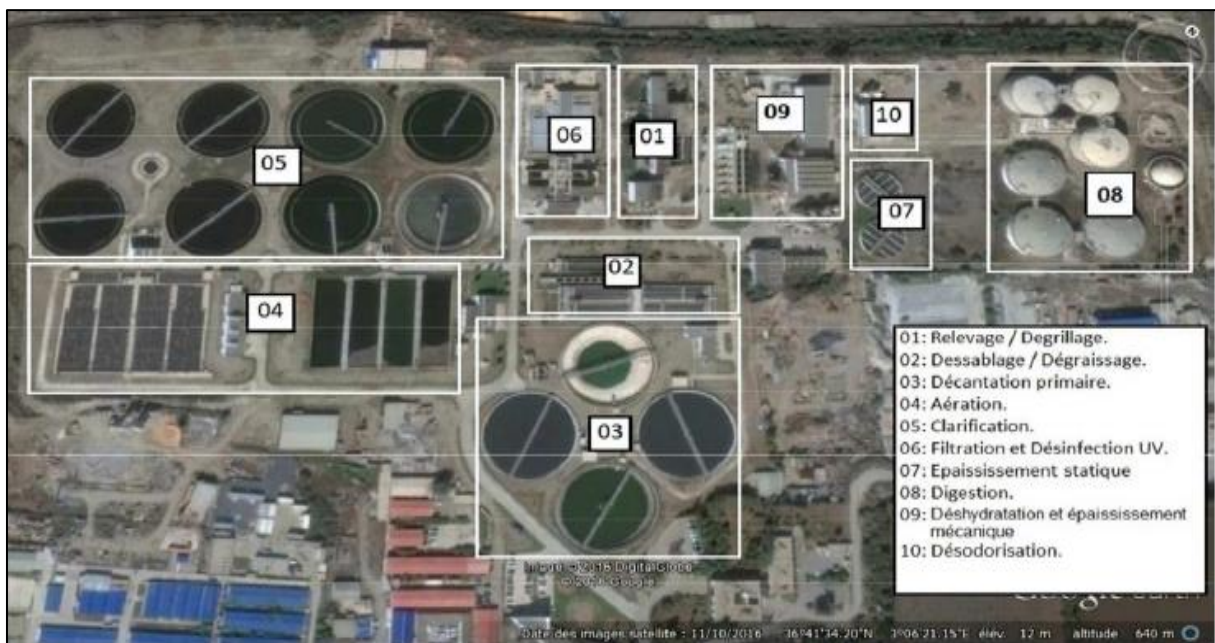
Figure II.1. Vue aérienne de la STEP de Baraki
