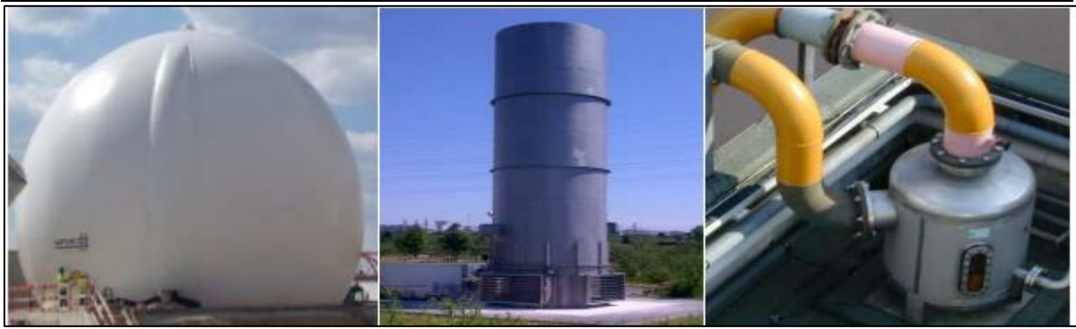
Figure II.35. Gazomètre de stockage de biogaz, torchère et pot de purge
