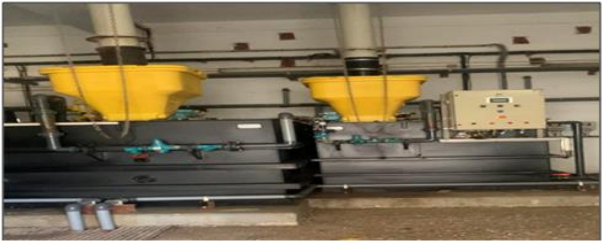
Figure II.27. Bac de préparation de polymère (selon terrain)
