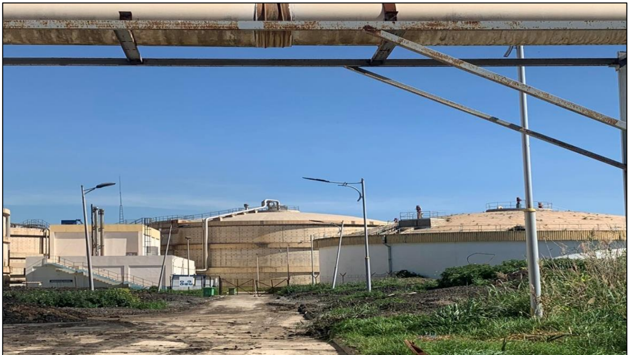
Figure II.32. Digesteurs dans la STEP de BARAKI 2023(selon terrain)
