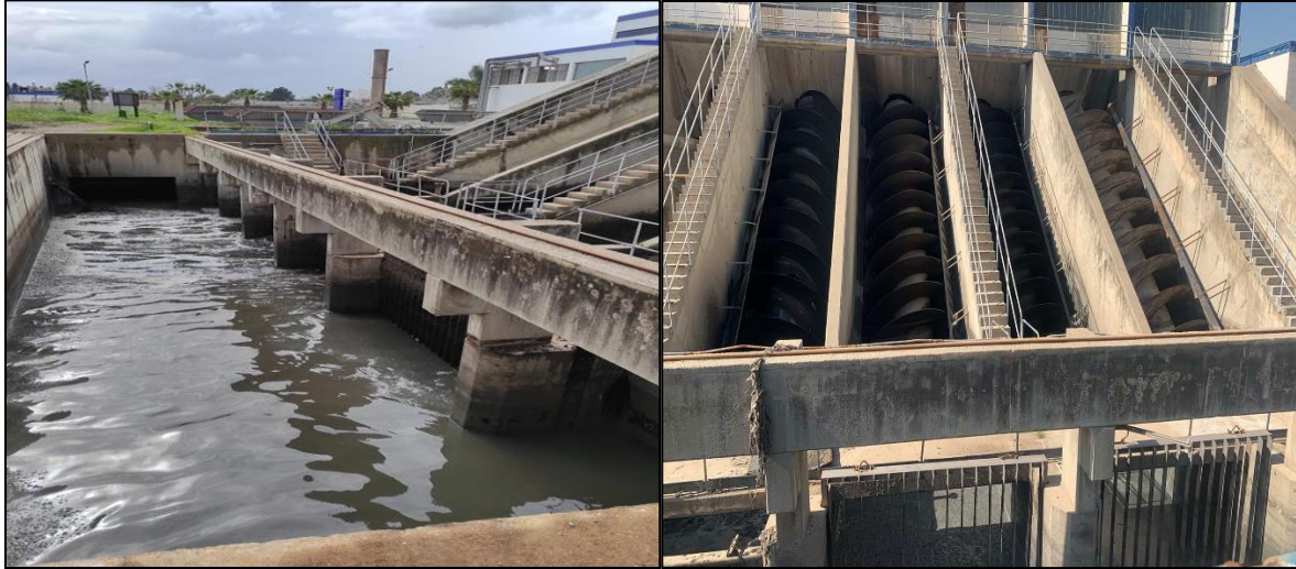
Figure II.6. Poste de relevage PR2 de la STEP Baraki, année 2023(photo prise sur terrain)
