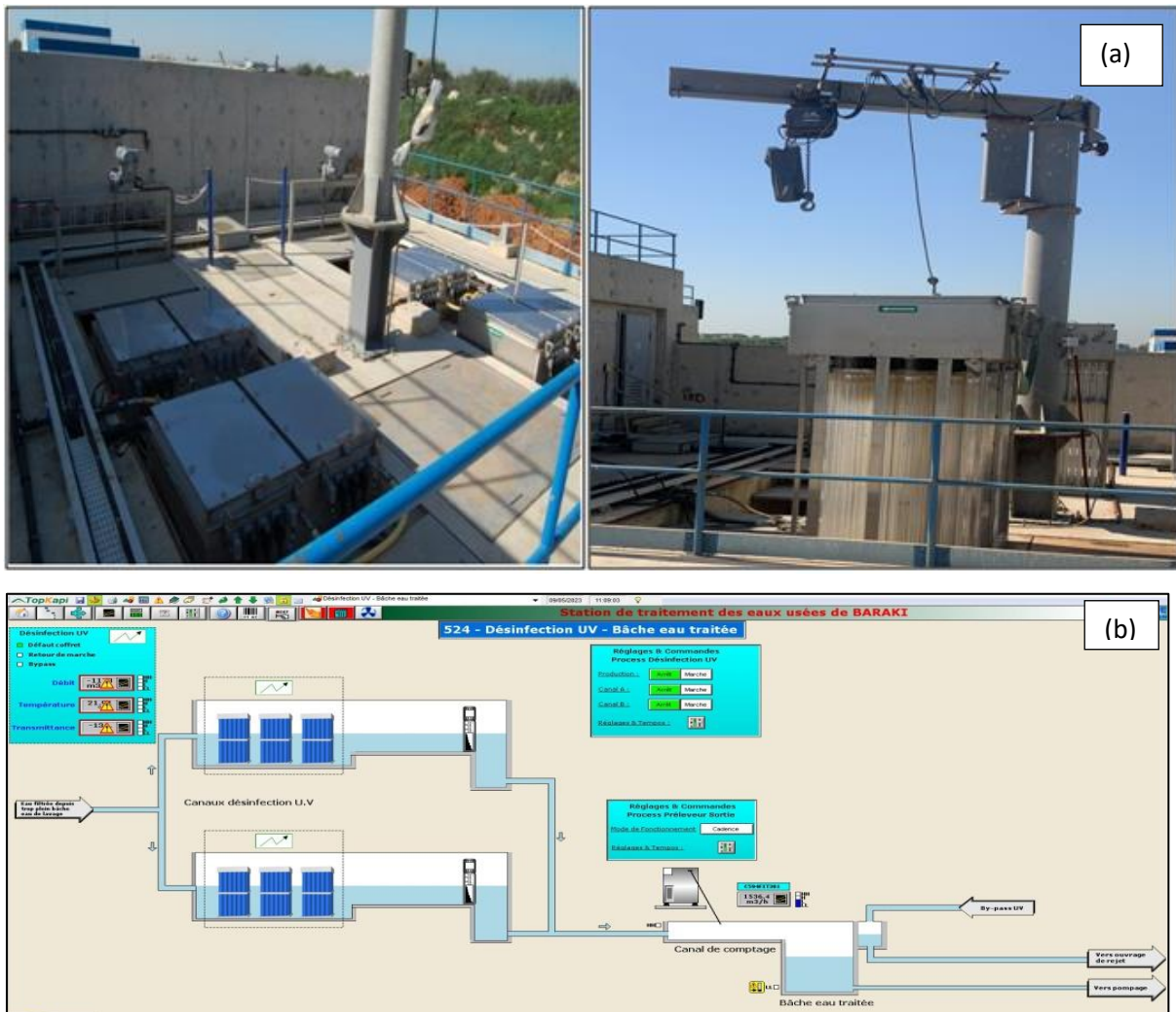
Figure II. 21. (a) Désinfection par les lampes UV (prise dans terrain 2023)
