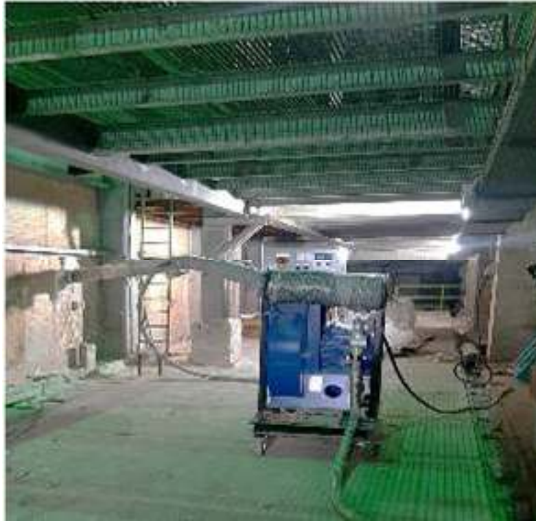
Figure IV.22 : Bruleur FOSBEL pour décolmater les fines particules.
