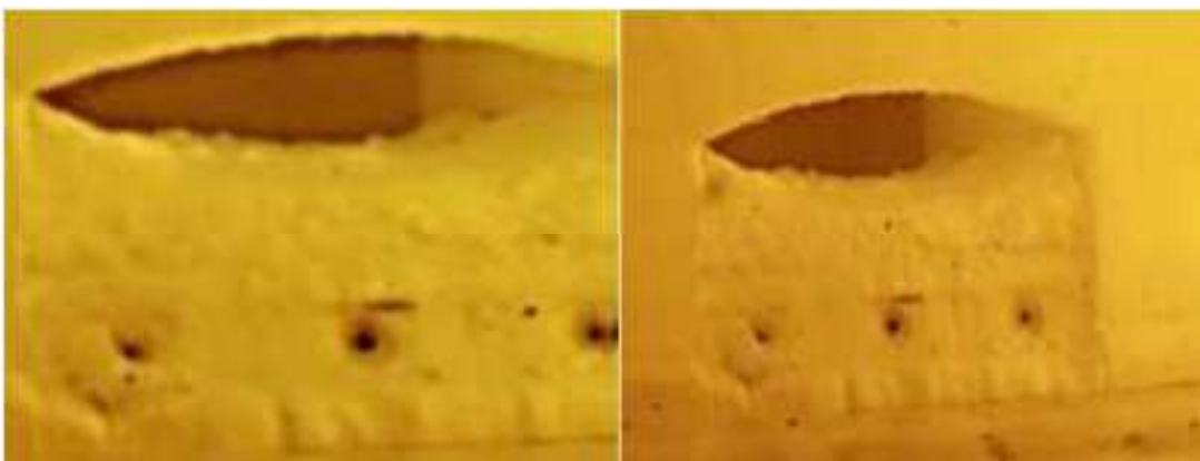
Figure IV.17 : Conduites de gaz bouchées par les particules fines.
