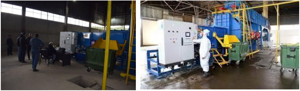
Figure II.4 : Incinérateur des déchets infectieux de l'EPIC EPWG-CET de Blida.
