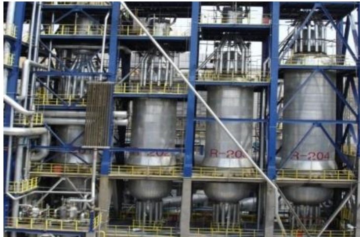
Figure A-3: illustration des 4 réacteurs en série de l'unité CCR
