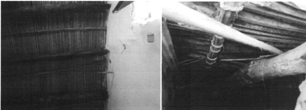
Figure 12 : Poutraison en tronc de palmier et plafond en clayonnage d'unemaison à Ksar El Mihane àDjanet. Source : Auteur
