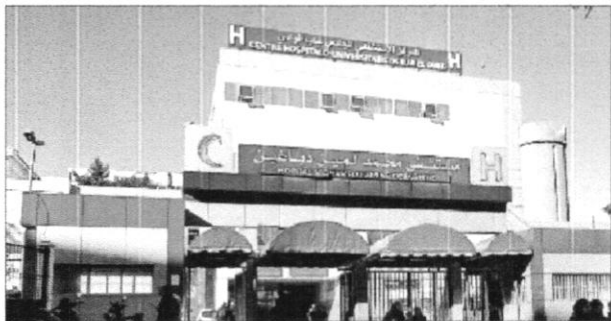
Figure 01: Hôpital Lamine Debaghine (Maillot) Source: Auteurs 2018
