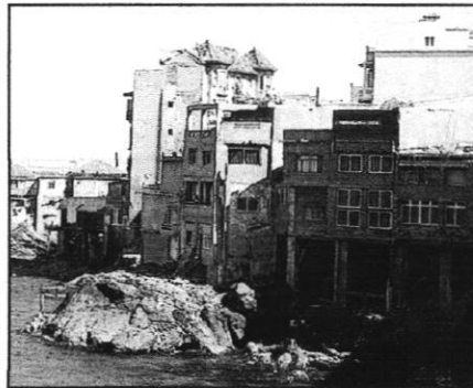
FIG I.13 : Immeuble effondré par le séisme du Bologhine 2011. Source : Auteurs 2018.
