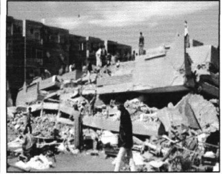
FIG I.11 : Séisme d'Alger 2003. Source : www.lematindz.net
