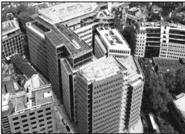
Fig. II.14 : Les façades du central saint Giles. Source: www.centralsaintgiles.com
