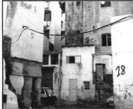
FIG I.16 : Vétusté de bâtis de Bâb el oued. Source : Auteurs 2018.
