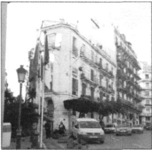
Figure 02: Vue sur les immeubles de rapport de la cité Bugeaud. Source: Auteurs 2018
