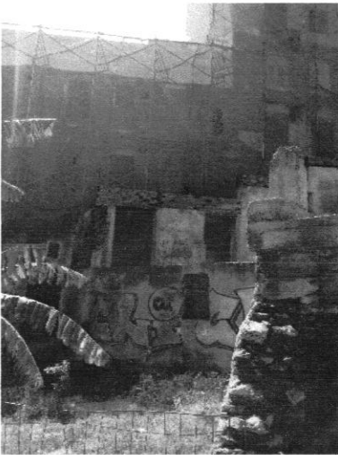
FIG I.6 : une maison en ruine au niveau de l'îlot Lallahoum Source : Auteurs Mars 2018
