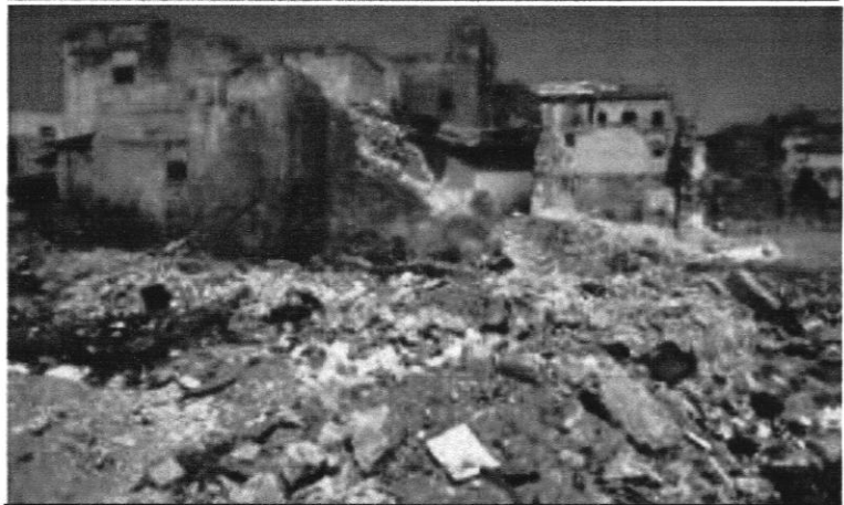
FIGII.10 : Photo état de ruine et l'intervention insalubrité du quartier. Source : https://archnet.org/sites/910/media_contents/985
