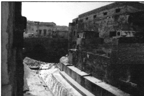
FIG II.2 : Photo du pont et la rivière de Lalla Yeddouna
