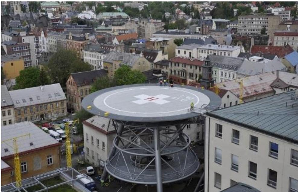
**Figure I. 4 :** Hélistation en terrasse (aluminium).
