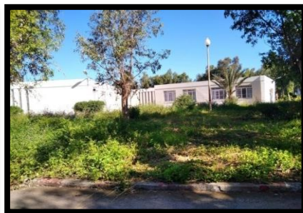
Fig42: Façade Sud du pavillon 02.
