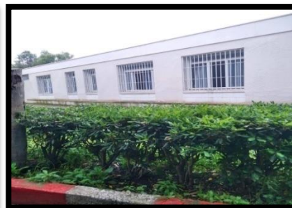
Fig43: Façade Est du pavillon 02.
