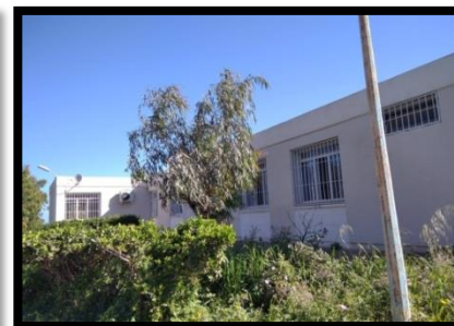
Fig44: Façade Ouest du pavillon 02.
