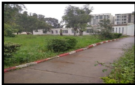
Fig41: Façade Nord du pavillon 02.
