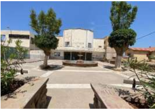
Figure 89 : Théâtre avant réhabilitation Source : Auteur
