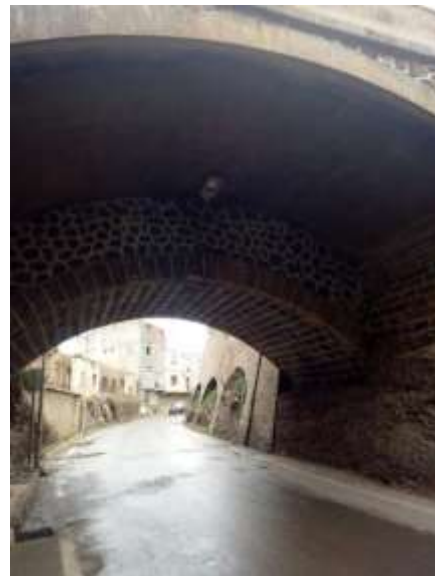
Tunnel en maçonnerie
