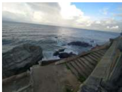
Escaliers en maçonneries
