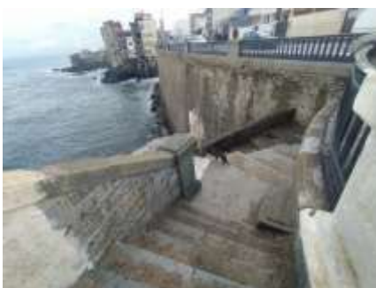
Escaliers en maçonneries
