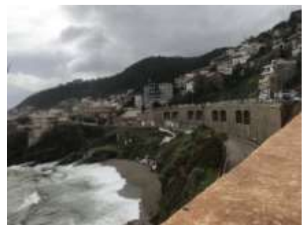
Mur de soutènement en pierre
