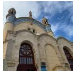
Figure 16: l'accès à l'église source : Auteur
