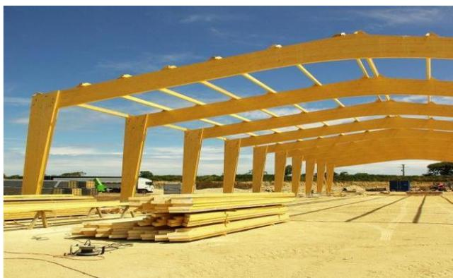
Figure105 : Structure en bois lamellé-collé
