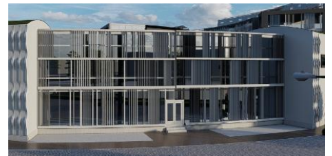
Figure 69 : Protection solaire verticale . Source : Auteur
