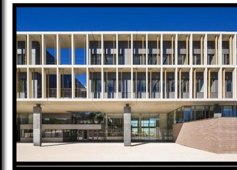
Façade principale Est
