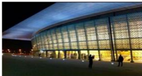
Vu sur façade sud
