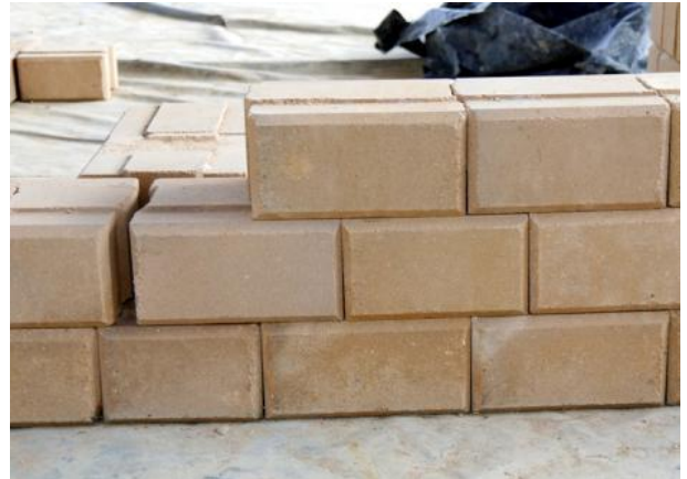
Figure 84 brique de terre compressée et stabilisé
