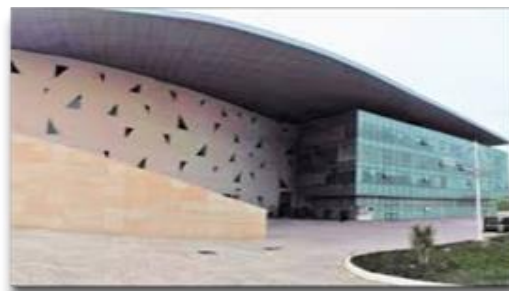
Vu sur façade est
