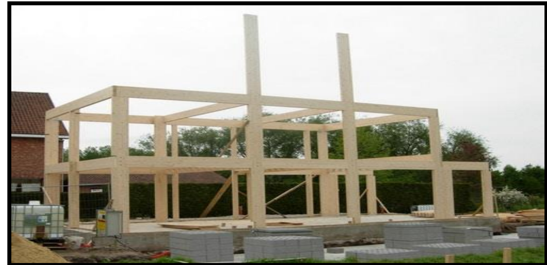
Figure148 : poteaux poutres en béton Source : https://www.livios.be/fr/info-construction/guide-du-logement/construire/techniques-de-construction/46760/systeme-poteaux-poutres/
