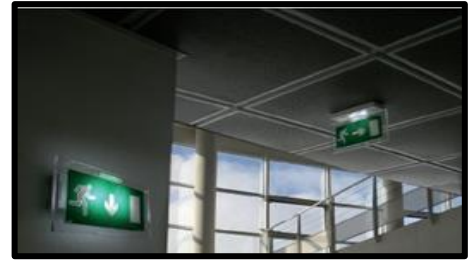
Figure : les issues de secours.
