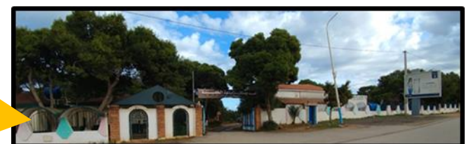
Figure36: le parc de la belle crête, source : les auteurs.
