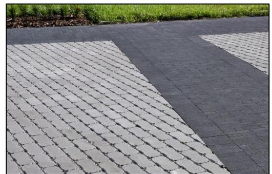
Figure 55: Pavé en béton poreux
