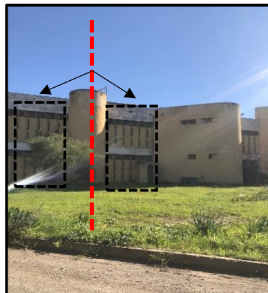
Figure : Façade département. Source : Prise par Auteurs 2022.
