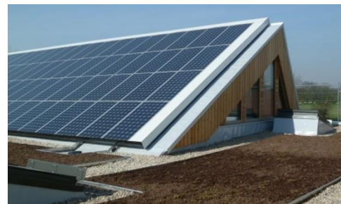
Figure n°33 : L'installation d'une toiture solaire. (Source : guide-toiture.com)
