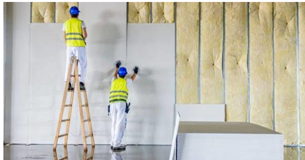
Figure n°18 : Isolation thermique intérieure. (Source conseils-thermiques.org)
