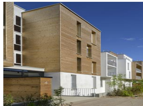
Figure 109 : façade arrière du projet
