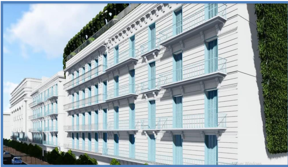
Figure.69 : facade principale du projet
