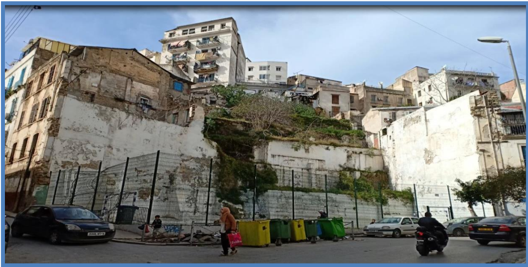
Figure.55 : Une photo du petit stade du quartier de Susatara.
