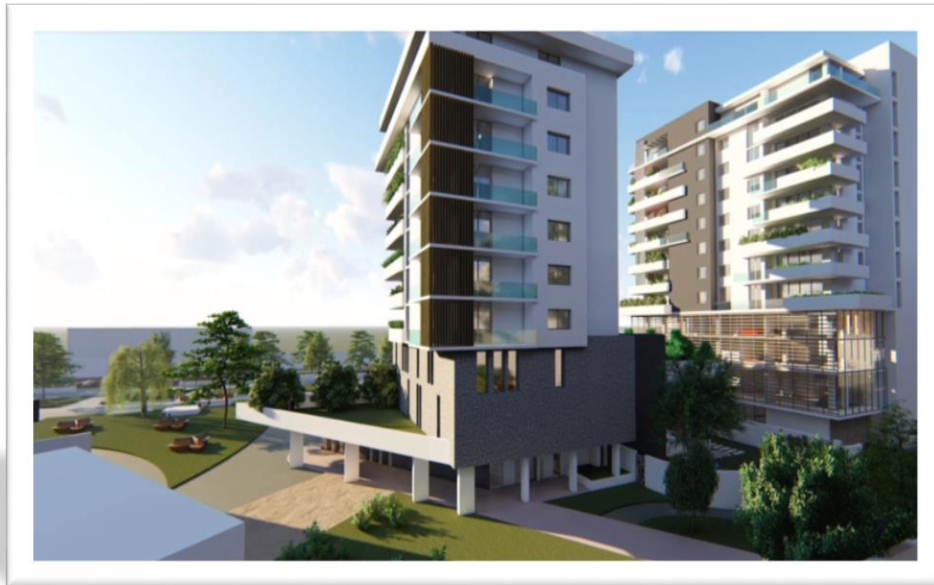
Figure.44 : Vue du Complexe résidentiel.
