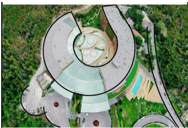
Figure 1:Eskisehir SPA & Thermal Hôtel .
