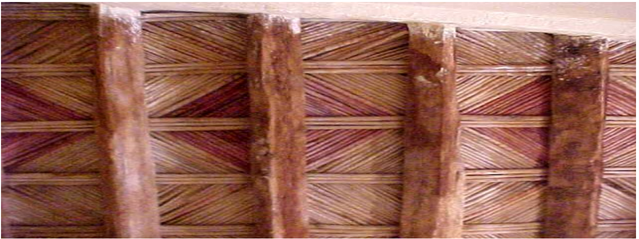
Figure 2.58 : lattis serré de tiges de roseau à Boussemgoun
