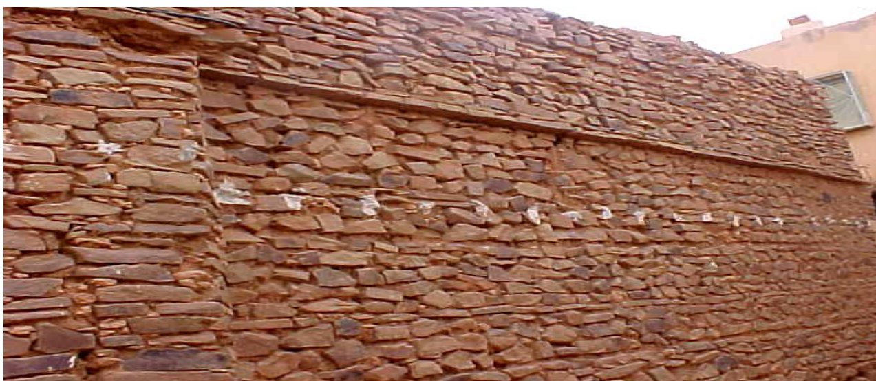
Figure 2.56 : construction en pierre à Kenadsa
