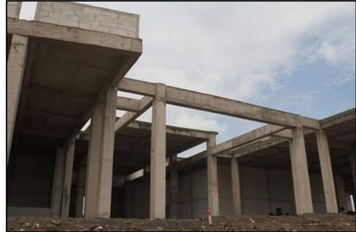
Figure 94 : système structurel poteaux poutres.
