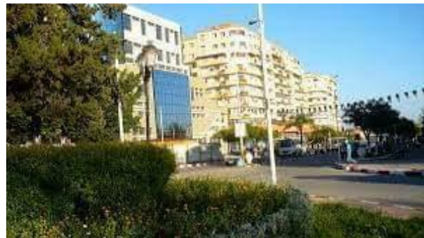
Figure 47: photo sur le projet de la remonte
