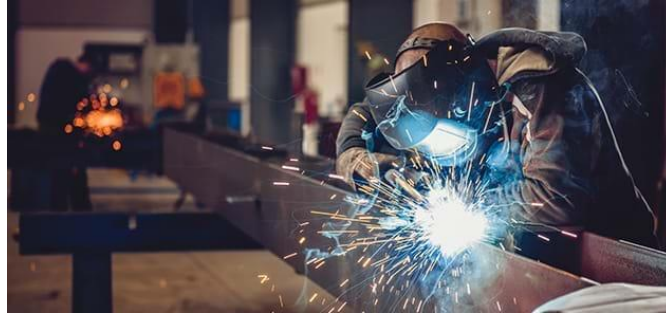
Figure I.5 : La soudure de l'élément.
