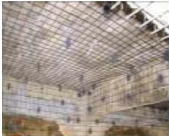
Figure 14 : Réalcalinisation du béton par installation du treillis anode sur l'intrados du
