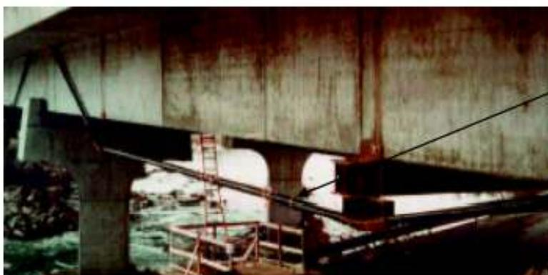
Figure 22 : Précontrainte provisoire mise en place pendant les travaux de remplacement de la précontrainte existante.
