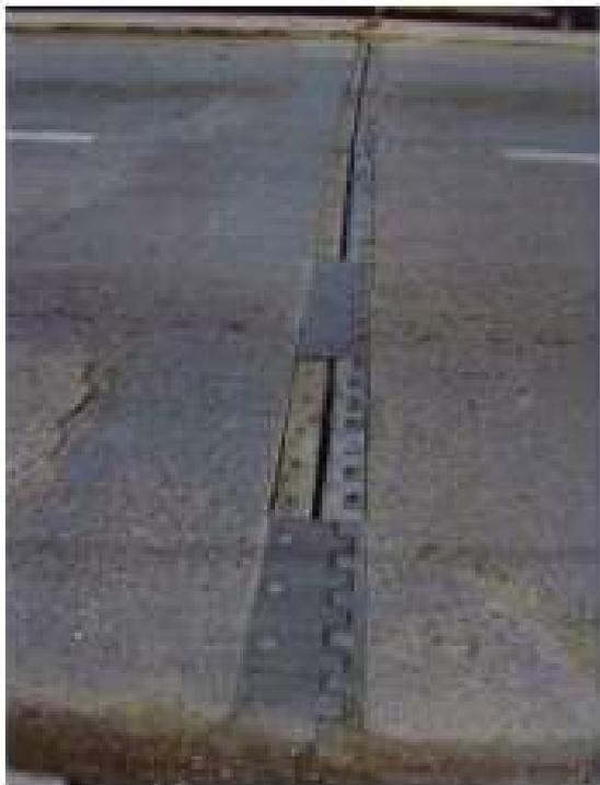
Figure 9 : Joint de chaussée fortement endommagé : arrachement de plusieurs éléments du joint sous l'effet du trafic routier.
