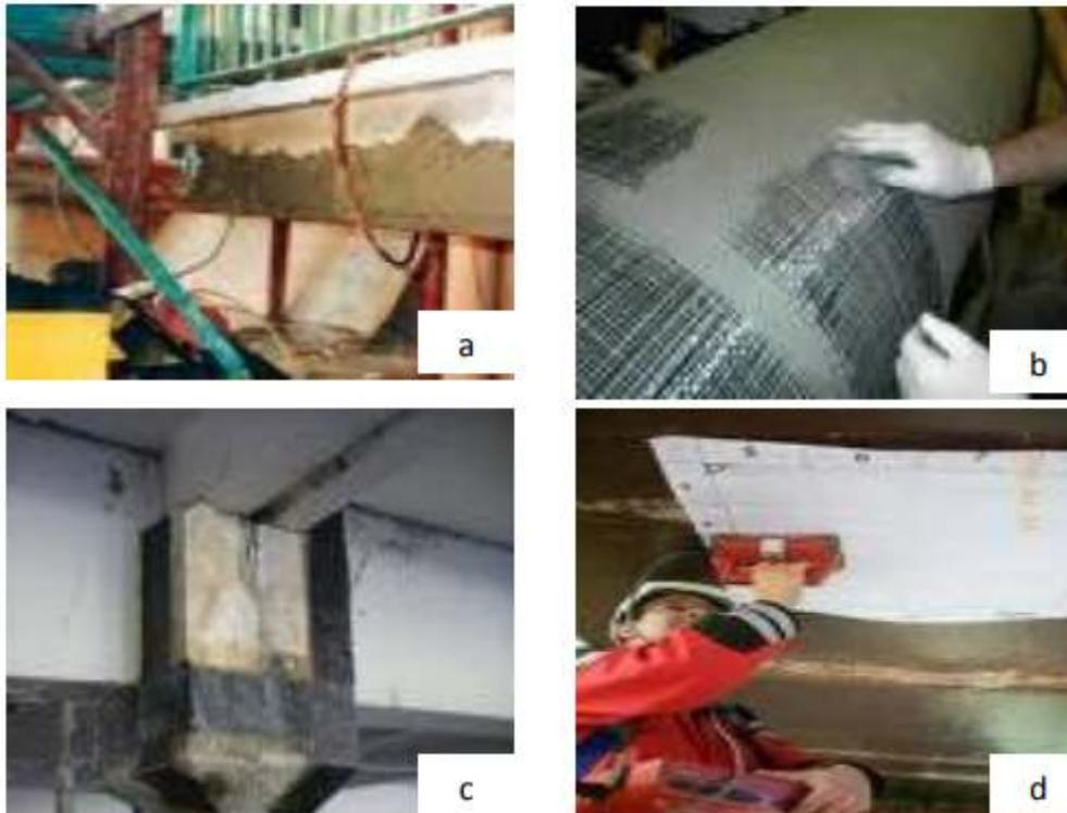
Figure 13 : Réparation/renforcement par ajout de matière : (a) béton, (b et c) tissus à fibre de carbone et (d) tôle métallique.)
