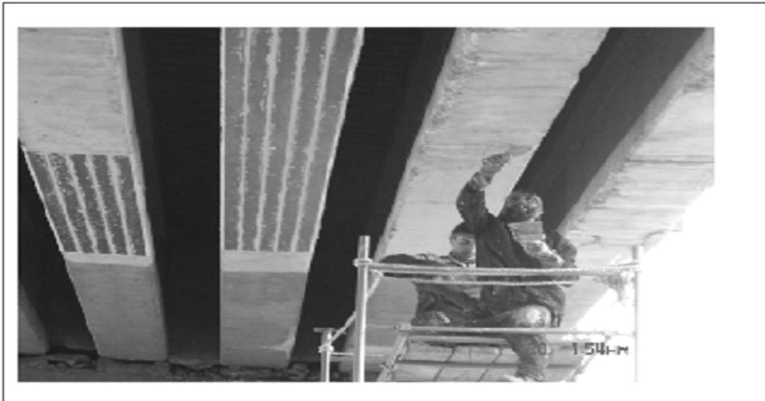
Figure 29 : Pose de tissu en fibres de carbone sur les poutres du tablier [14]
