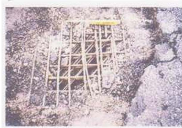
Figure 10 : Etanchéité et dalle en état très détérioré.
