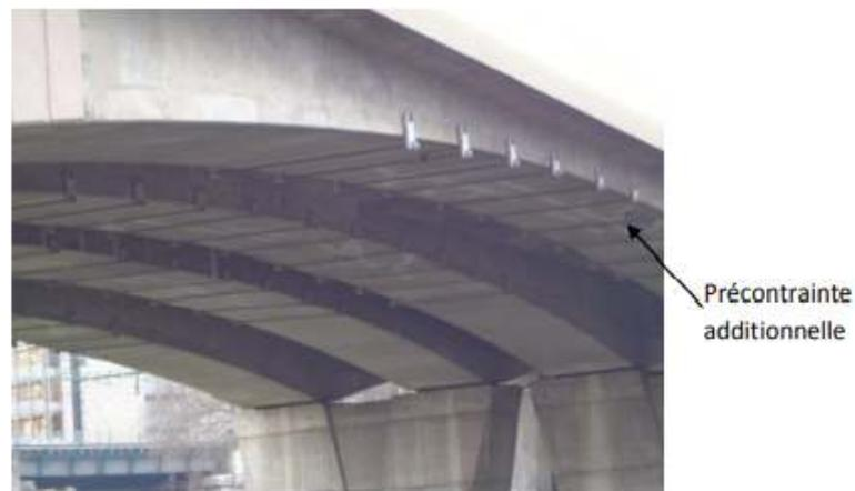
Figure 17 : Renforcement dans le sens transversal du hourdis inférieur de deux ponts à caissons sur la Saône (France) par précontrainte additionnelle.
