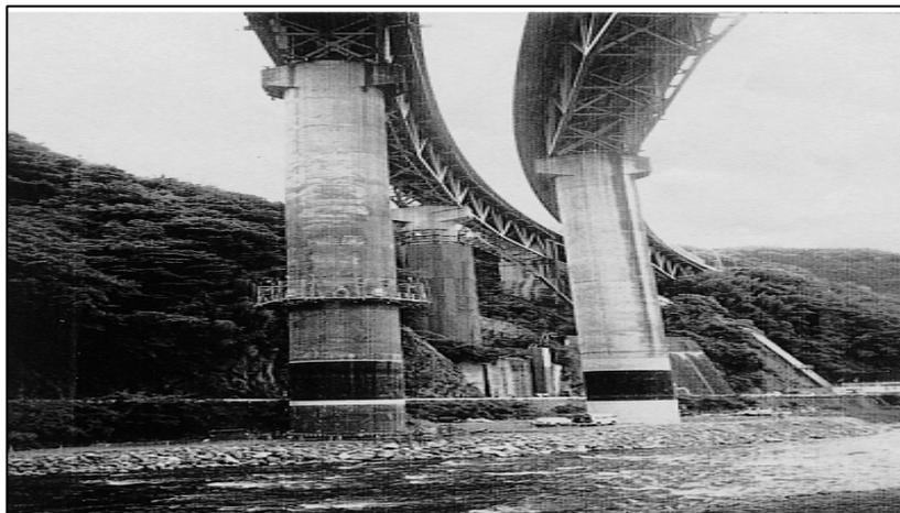
Figure 27 : Renforcement des piles de pont (Sakawa River-Japon). [11]
