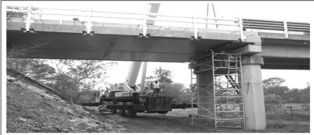
Figure 28 : Installation des premiers composites FRP ‘‘Australiens’’ sur un pont. [13]
