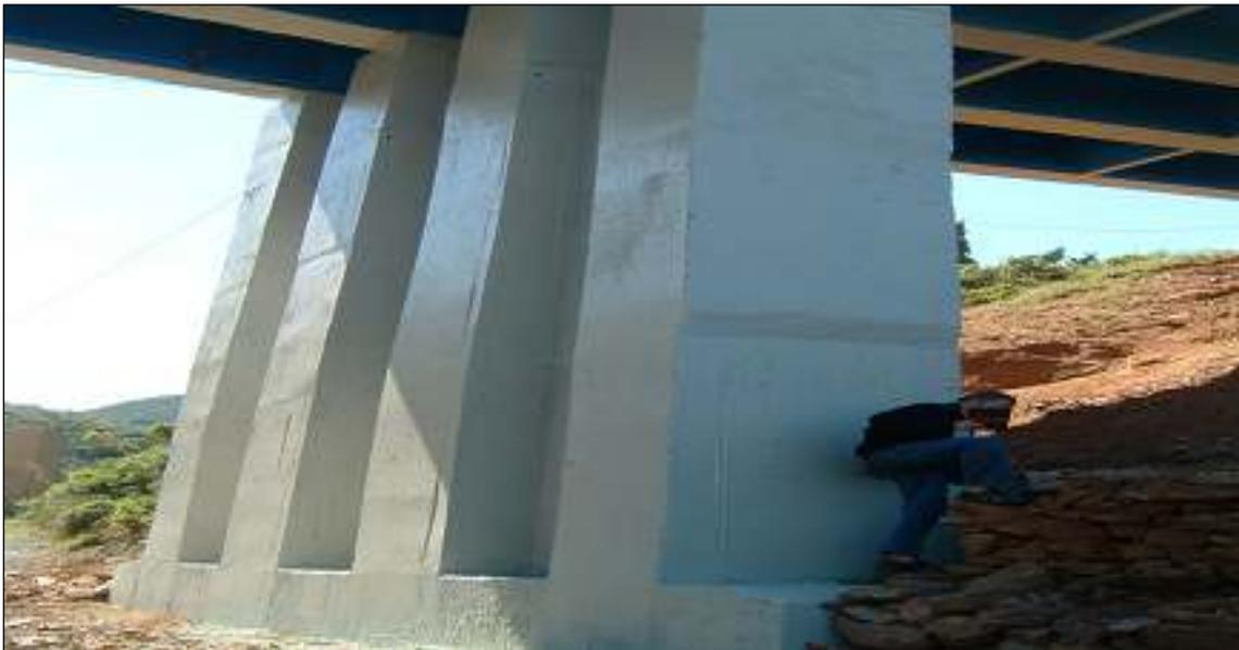
Figure 32 : Pile du pont après sa réparation. [13]
