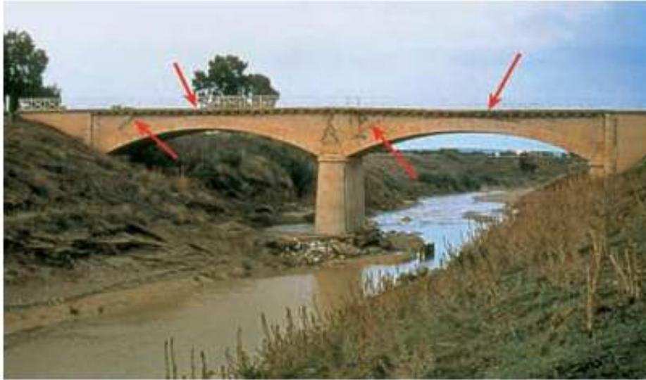
Figure 11 : Tassement de la pile médiane d'un pont due à l'affouillement local de sa fondation. [6]
