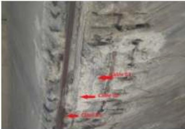
Figure 21 : Précontrainte endommagée sous l'effet des chocs de véhicules (pont sur l'échangeur de la rampe des Fusillés-Alger)
