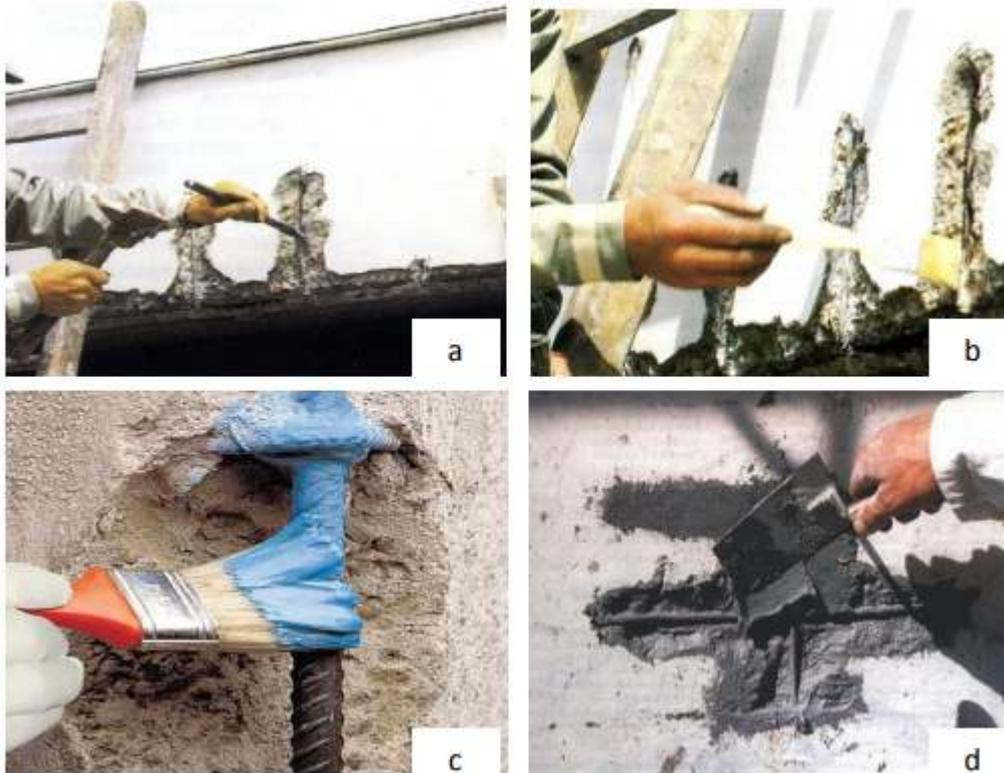
Figure 15 : Réparation d'armatures corrodées : (a) refoulement des armatures, (b) élimination de la corrosion, (c) passivation des armatures et (d) réfection des bétons
