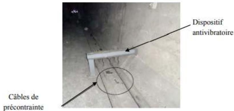
Figure 18 : Renforcement par précontrainte additionnelle longitudinale d'un pont à caissons sur le Rhône (France)
