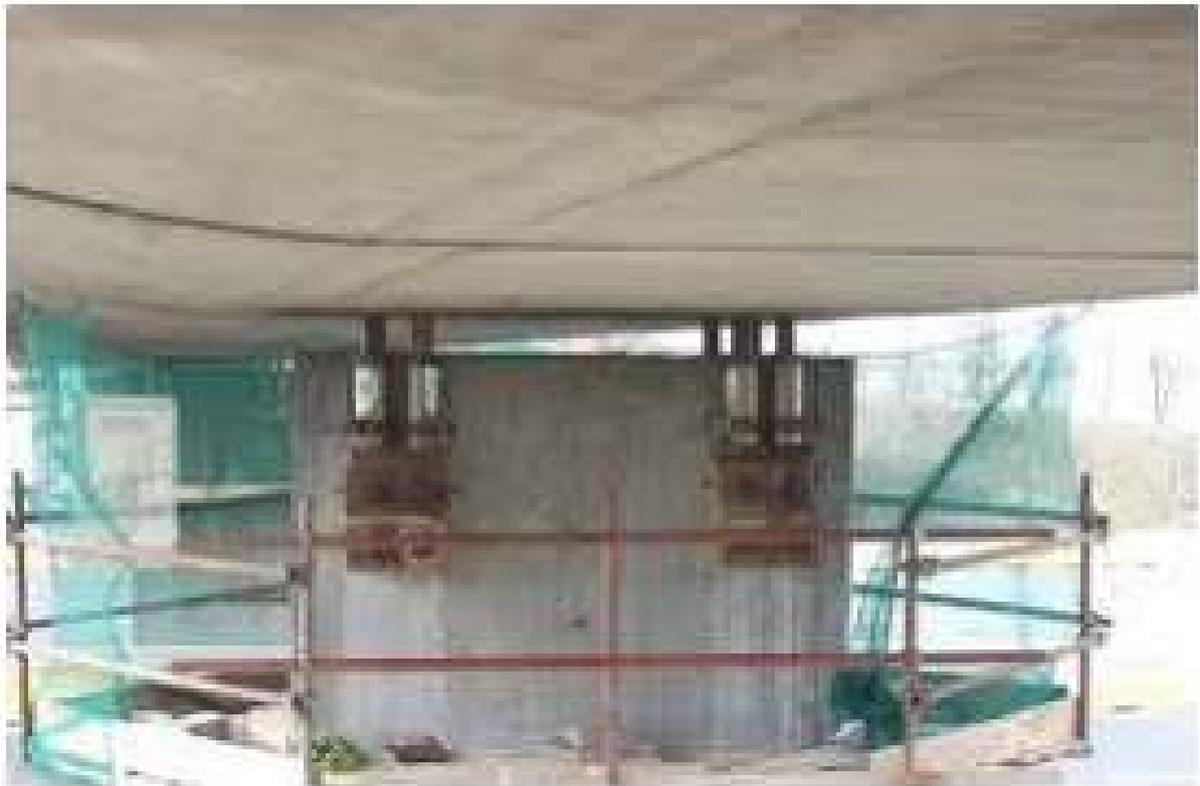
Figure 23 : Relevage par vérins plats du tablier d'un pont (Pont PS 308 à Saint Laurent de Mure (France)).
