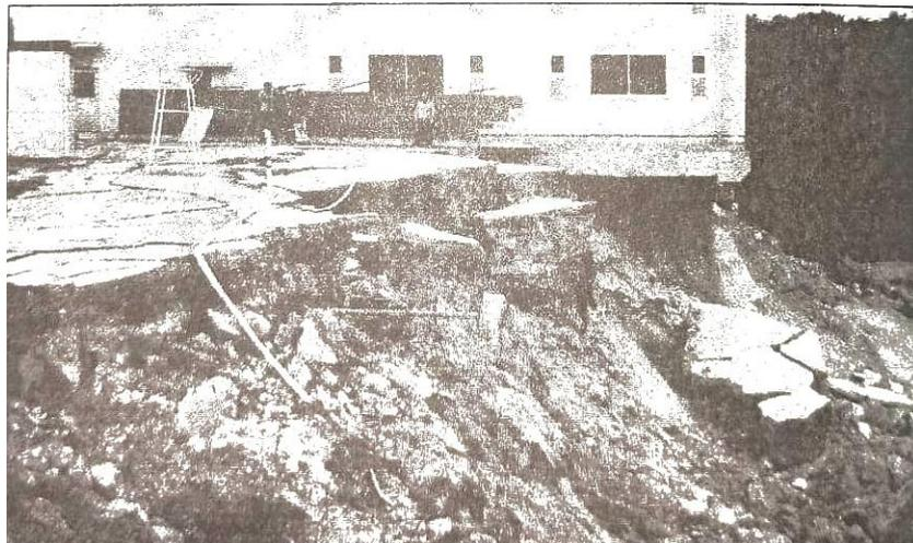
**Figure I.2** : Glissement d'un talus rocheux suite au séisme de Kobé (Japon) [1].
