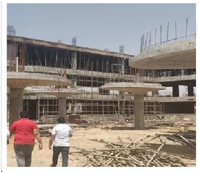
Figure 16: Construction des poteaux champignon en béton armé.
