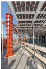
Le coulage des poteaux inclinés
