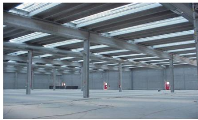
Structure auto stable a l'intérieur
