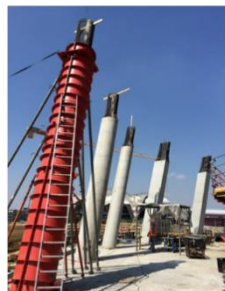
Le coulage des poteaux inclinés
