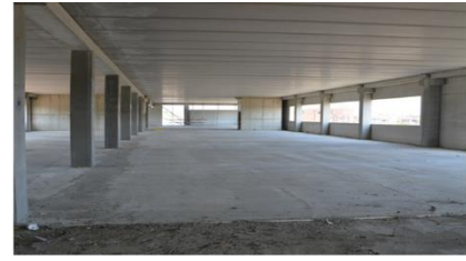
Structure poteaux poutres en béton armé
