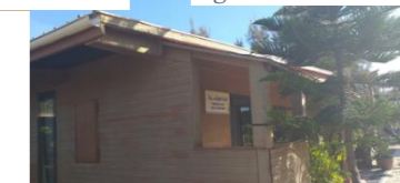
Figure 123: l'enveloppe d'un bâtiment à la ferme
