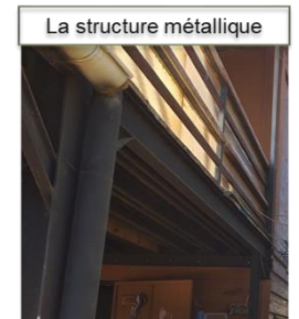
Figure 125: la structure métallique
