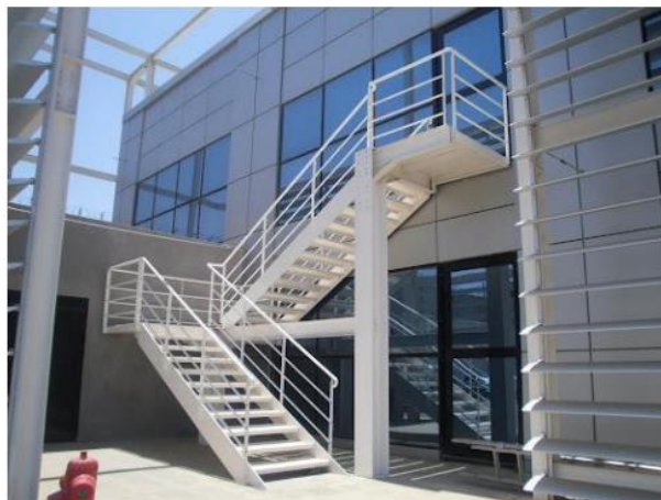
Figure 1.3 : Escalier en charpente métallique.
