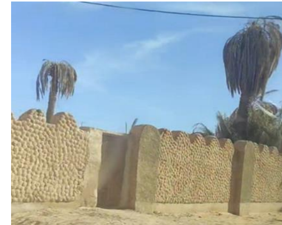
Figure 46: revêtement extérieur. Source : auteurs 2023
