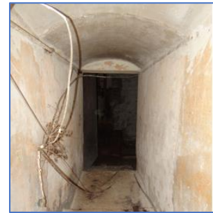
Figure 22 : Entrée en chicane, bousaada
