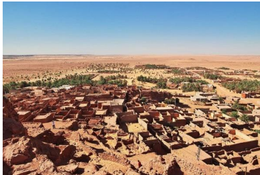
Figure III.83 : ksar de Timimoune Source :
