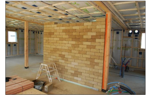
Figure III.172 : mur cloison avec BTC
