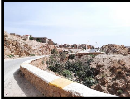
Figure 57: mur de soutènement du moulin
