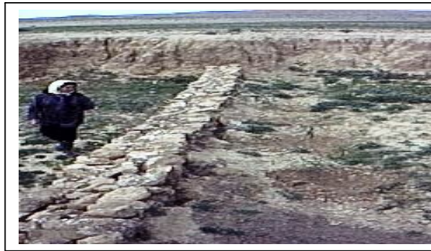
Photo 5.2 Seuil en pierres sèches (ravine en U)
