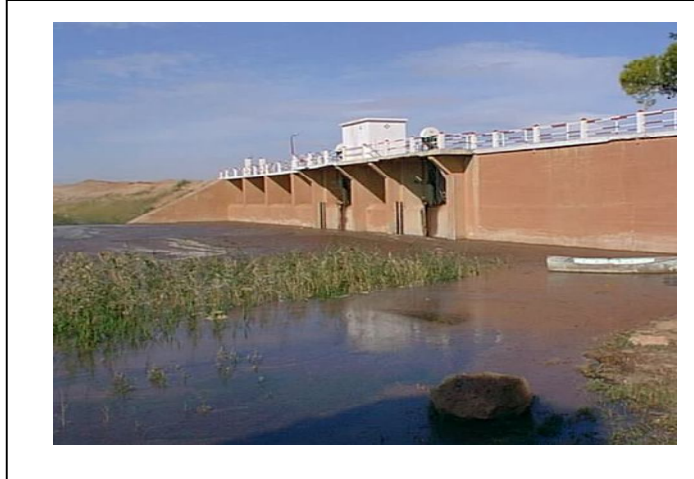
Figure 2.5 Digue principale du barrage de Boughzoul
