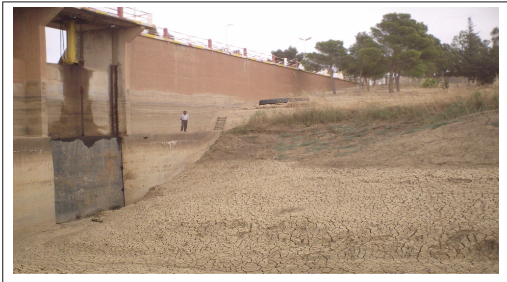
Figure 2.8 Etat d'envasement de la retenue de Boughzoul
