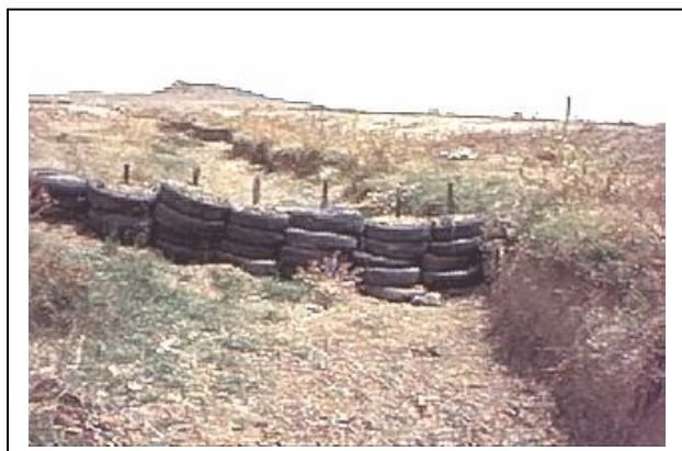
Photo 5.7 Seuil en pneus usés (Avant)
