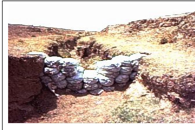
Photo 5.6 Seuil en sacs plastiques
