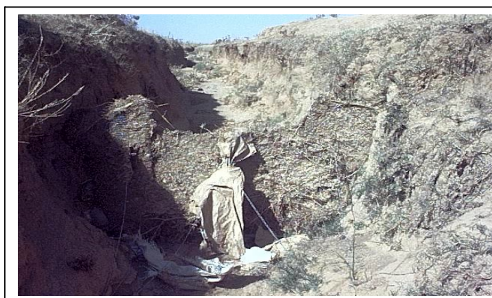
Photo 5.5 Seuil à grillage métallique (Après)
