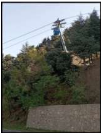
Figure 67: téléphérique source: auteurs
