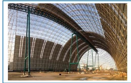
Figure 234 : Structure en coque tridimensionnelle.
