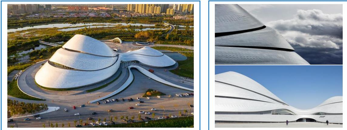
Figure 221 : Panneaux en aluminium de Harbin Opéra.
