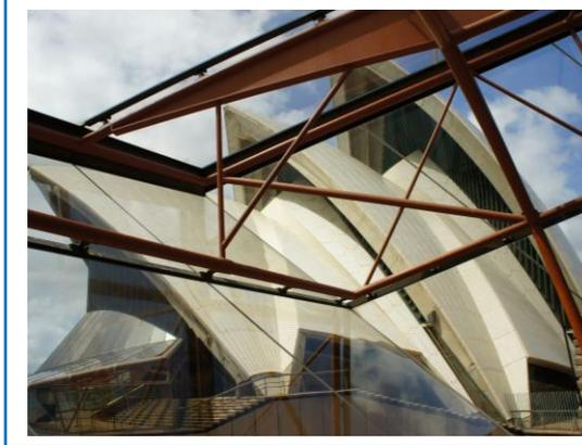
Figure 201 : L'ossature en acier dans les façades.
