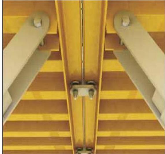
**Figure I.12: deux panneaux horizontaux solidarisés à l’aide verrous à clef.**
