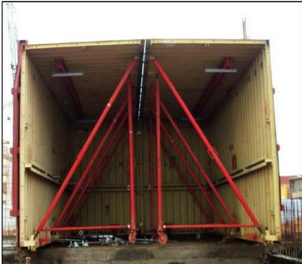
**Figure I.11: Assemblage de deux demi coquilles sur chantier .**
