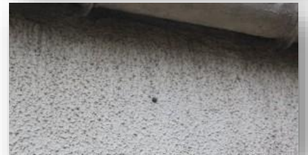
Figure 140 : étapes préparation du mur et réalisation du scellement chimique Source : Vince,2014, [Pergola Dossier 1] Le scellement chimique Fischer, https://www.zonetraavaux.fr/2014/02/pergola-scellement-chimique-fischer/ chimique
