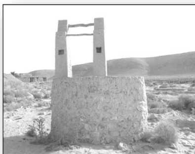
Figure 115 : Puits Loubira, premier puits réalisée dans la Vallée de Ghardaïa Source : Dahmen.A, Kassab.T ,2020, L'EAU A GHARDAIA (ALGERIE), UN SYSTEME ARTIFICIEL PAR EXCELLENCE
