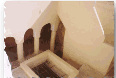
Figure 40 : terrasse Source : Bouaroua.N, 2017, la maison traditionnelle
