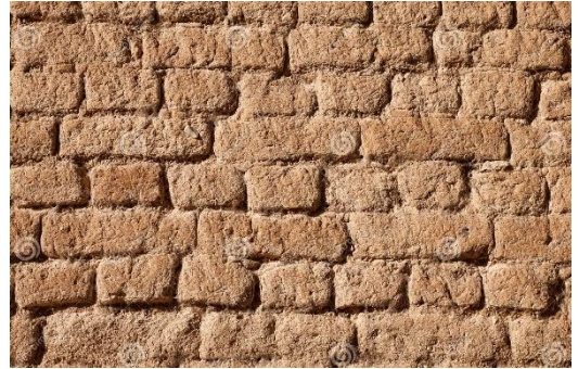
Figure 138 : Mur de briques d'Adobe Source : Demachy | Dreamstime.com
