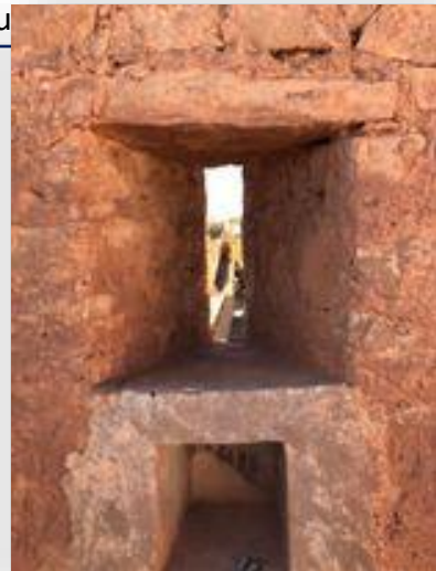
Ces ouvertures sont faites pour mettre leurs armes et tirer et la forme est étudié pour bien viser et être en sécurité
