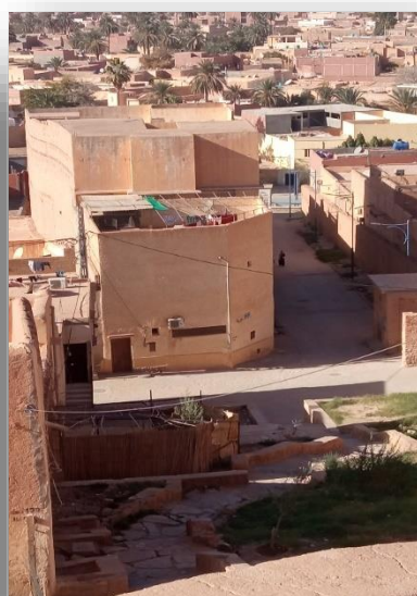
Les façades sont presque aveugles avec peu d'ouvertures, généralement le gabarit est R+1
