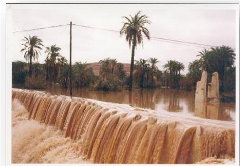
Figure 114 : le barrage Source :bensaha.H , bensaha .I ,Achour.M , réflexion pour préserver l'environnement, cas de la vallée du Mzab
