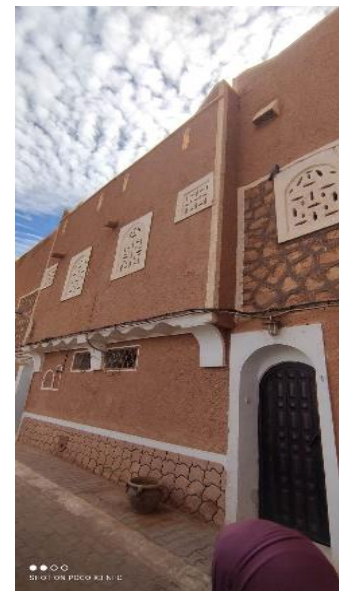
Figure 58 : Façade d'une maison à Tafilelt
