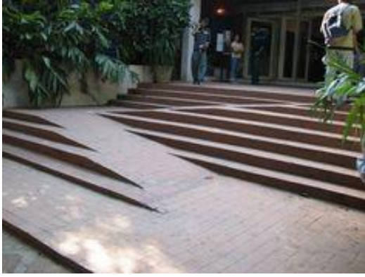
Figure 33 : Un exemple de rampe pour les PMR
