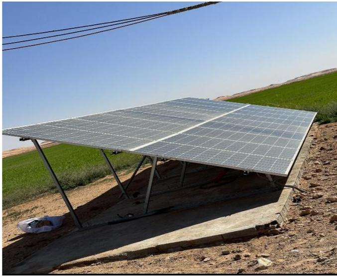
Figure III.2 et III.3 représente une association de série parallèle des modules photovoltaïque
