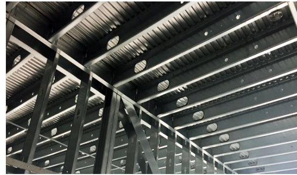
Figure 150 : les solives / source : https://www.bmp-group.com/fr/produits/Syst%C3%A8mes-de-plancher-en-acier-1%C3%A9ger-LSF/syst%C3%A8me-de-solive-en-c-pour-plancher
