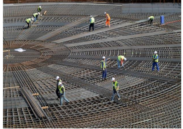
Figure 138 : Fondation en radier Source :
