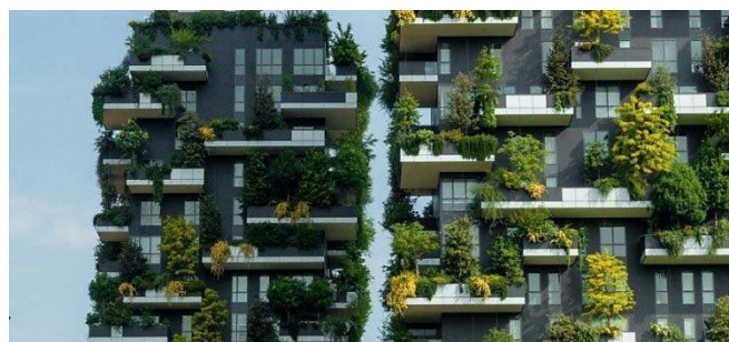
Figure 66: La tour végétale de Gerland ; Source : Martin Wimmer Getty Images
