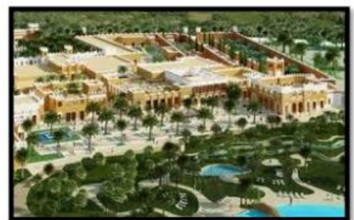
Figure 2-19 : vue générale sur l'oasis de noria
