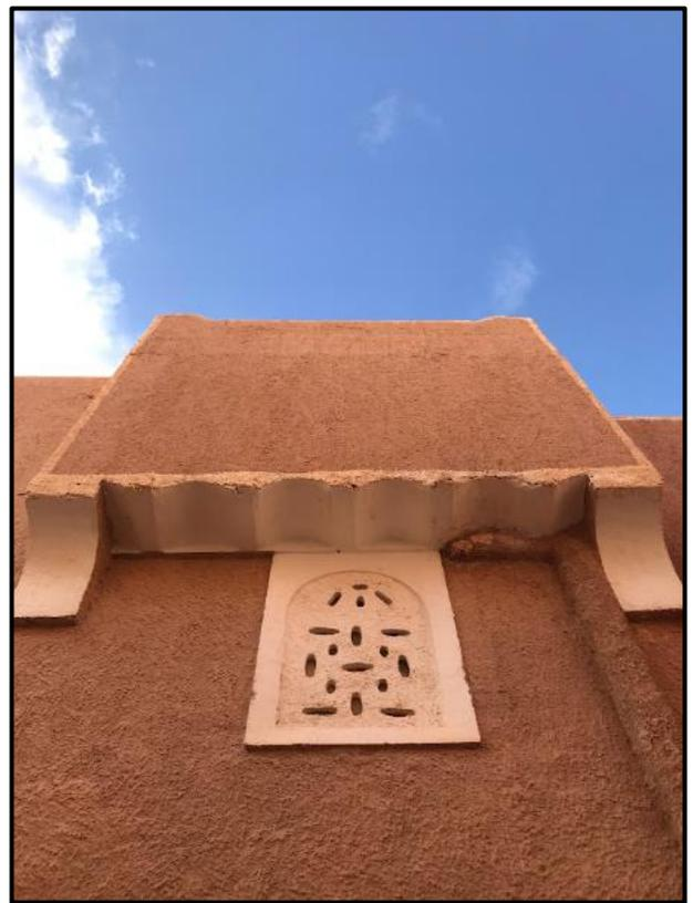
**Figure 172:** Photo de revêtement de mortier de chaux avec le régime de dattes sur la façade de la maison de Tafilalt
