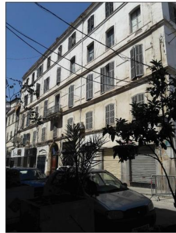
② Façade néoclassique (phase 01) sur la rue Ahmed Bouzrina
