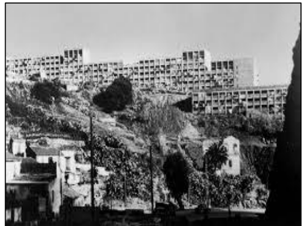
Figure 44. Ensemble d'habitation à Djenan El Hassan, Simounet
