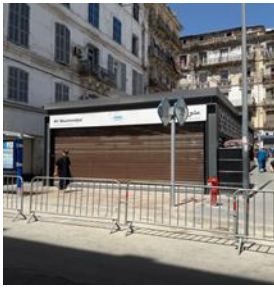
Figure 94. Accès « Marché » à station Ali Boumendjel
