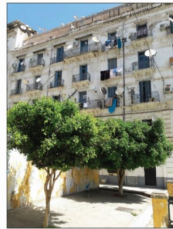
F Façade du bâtiment en moyen état
