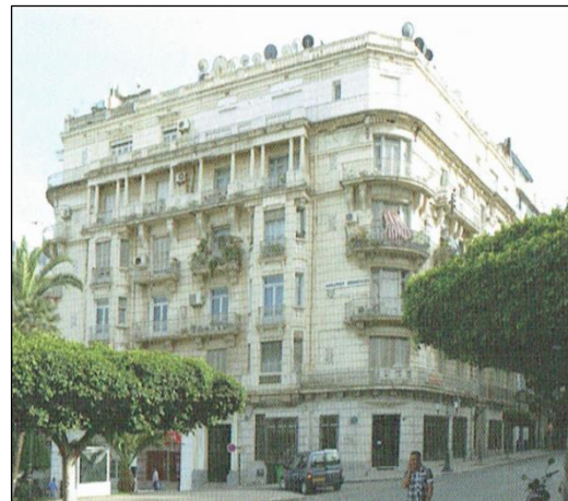
Figure 54. Immeuble de rapporte sur la rue Mohamed 5
