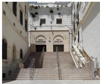
Figure 95. Accès « Théâtre » à Station métro Ali Boumendjel
