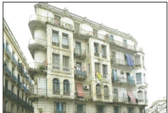
Figure 65. Immeuble de rapport de Bourgarel
