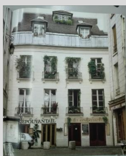
Immeuble de style de louis 14 Source : J.M Labordiére ,2000
