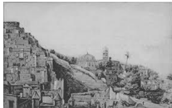
Figure 14. Mosquée sidi Abderrahmane
