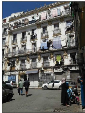
D Façade du bâtiment en moyen état
