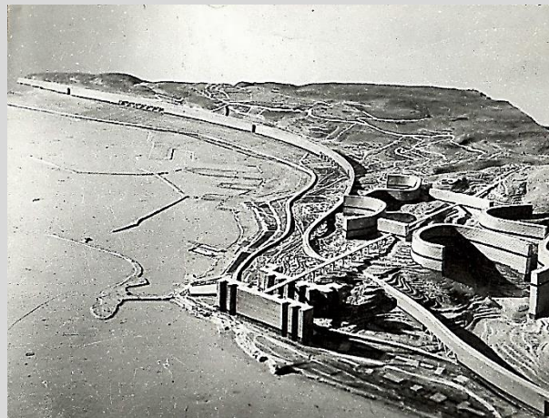
Figure 51. Vue aérienne du bâtiment-autostrade
