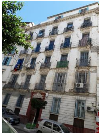
Figure 101. Bâtiment à restaurer, rue Debbih Cherrif
