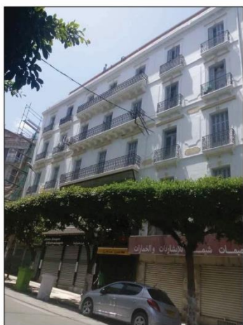
H Façade du bâtiment en bon état
