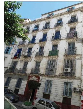
⑤ Façade néoclassique (phase 01) sur la rue Debbih Cherif
