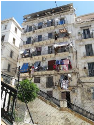
Figure 102. Bâtiment à réhabiliter, boulevard Ourida Meddad
