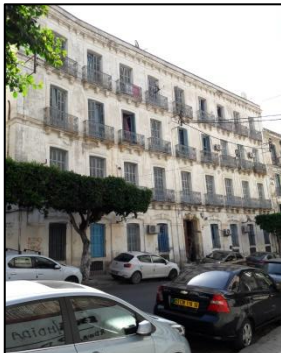
Figure 78. Bâtiment R+3, sur la rue Debbih Chérif
