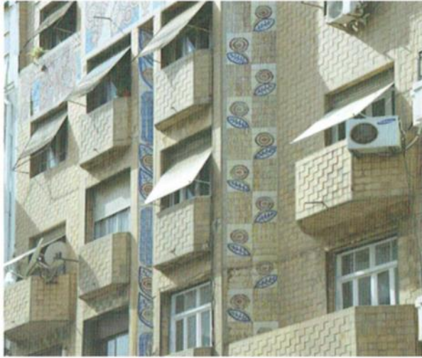
Figure 74. Immeuble d'habitation, rue Docteur Saadane
