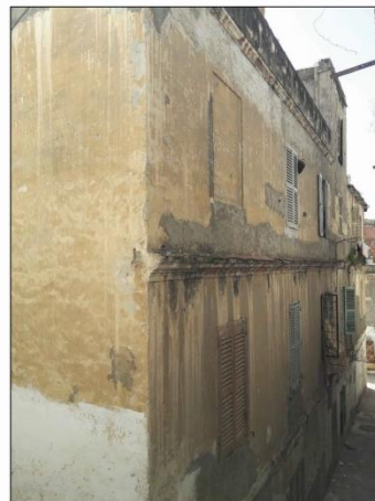
⑨ Façade sans aucun style reconnu
