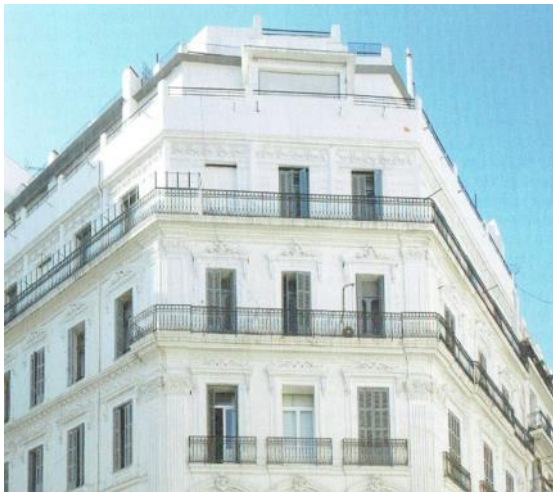
Figure 67. Immeuble de rapport, Ben M'hidi
