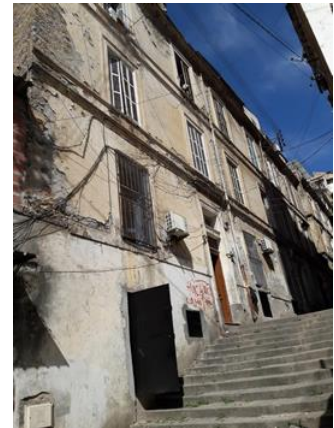
Figure 100. Batiment à démolir, rue Saïd Yattachane
