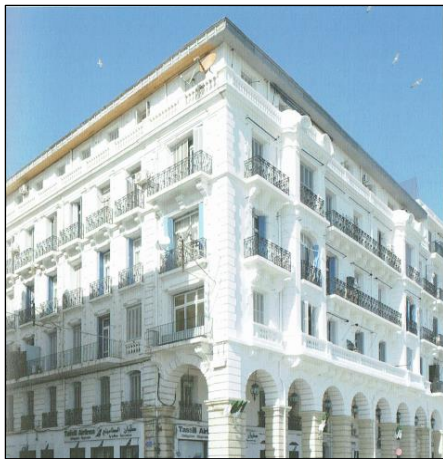
Figure 53. Immeuble de rapporte sur la rue Zigoud Youcef
