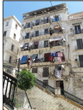
Figure 79. Bâtiment R+5, sur le boulevard Ourida Meddad
