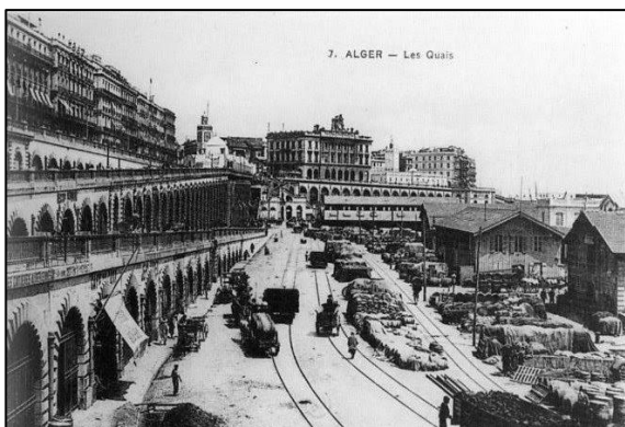
Figure 29. Chemin de fer principal sur le quai.
