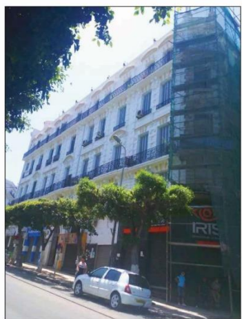
I Façade du bâtiment en bon état
